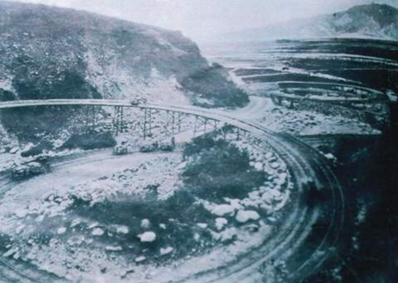
大安溪上的輕便鐵道，必須以盤旋方式登山。
